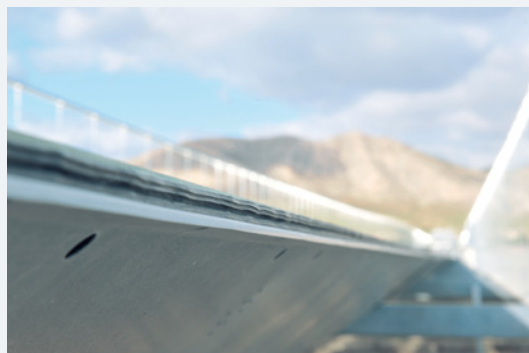
Malgrado l'intensa luce solare, l'adesivo Terostat MS mantiene gli specchi saldamente fissati ai telai d'acciaio.
