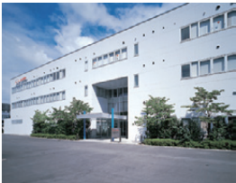
横浜／ アジアパシフィック技術センター
